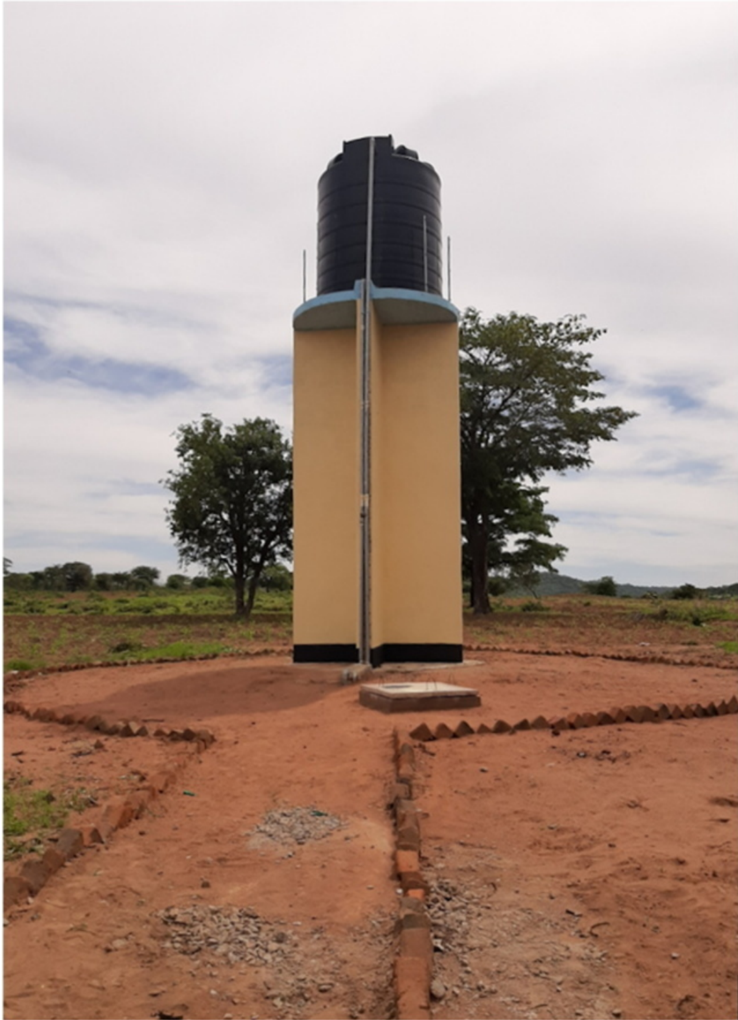
05 1 2020 Il serbatoio principale
