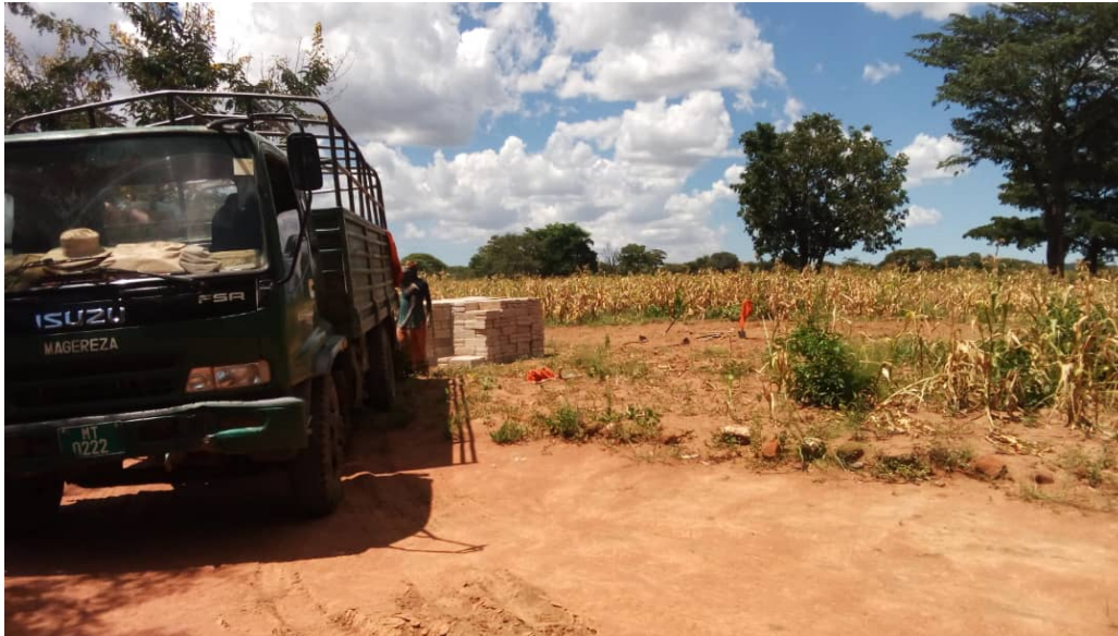
19 04 2019 Le fasi iniziali
